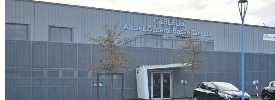
©Atelier Cablelec à Toulouse
