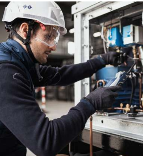
Collaborateur d'Axima Nucléaire sur une opération de contrôle de fuite sur un groupe froid ©Atypix
