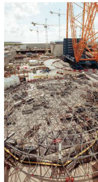
Chantier de construction d'Hinkley Point C, Grande Bretagne ©ClaireLiseHAVET
