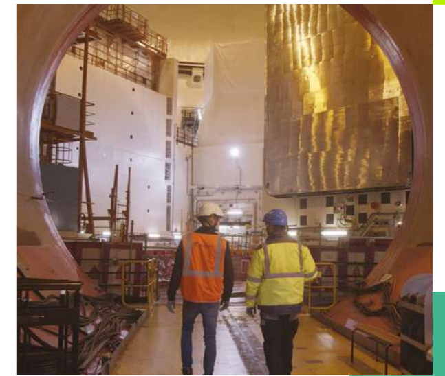
Chantier de construction de l'EPR Flamanville @Soxh
