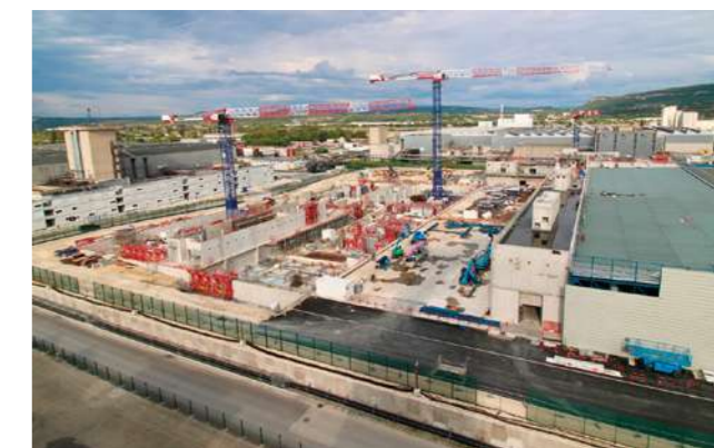
Chantier de l'extension de Georges Besse 2 ©CyrilCRESPEAU
