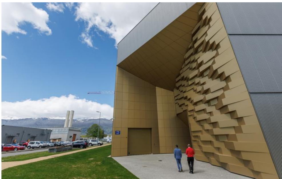
Le nouveau data center, installé sur le site de Prévessin-Moëns, regroupe six salles informatiques qui auront, à terme, une capacité de serveurs de 12 MW. Pour l'entrée monumentale, l'architecte a voulu symboliser un proton qui explose. Photo Le DL/Thierry Guillot
